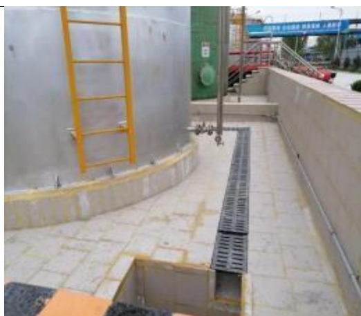
TMQ中间储罐
