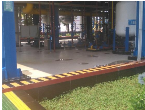
生产装置围堰
