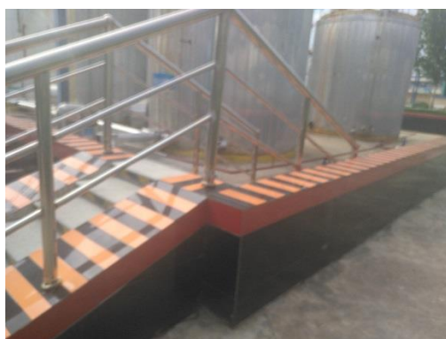
中间储罐区围堰
