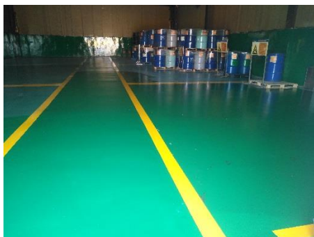
危废库内地面防渗
